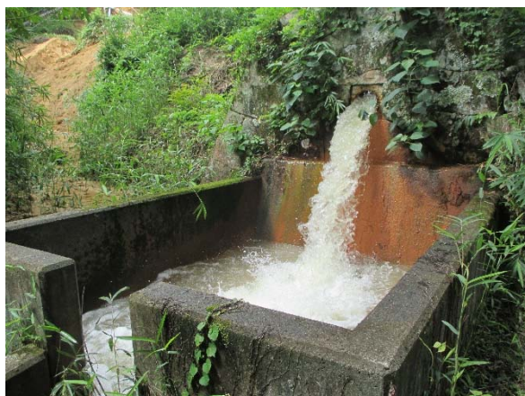
写真-2 底樋排水状況
