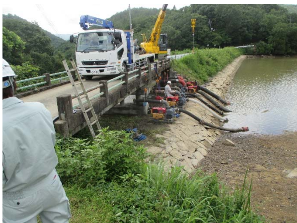
写真-3 ポンプ排水状況
