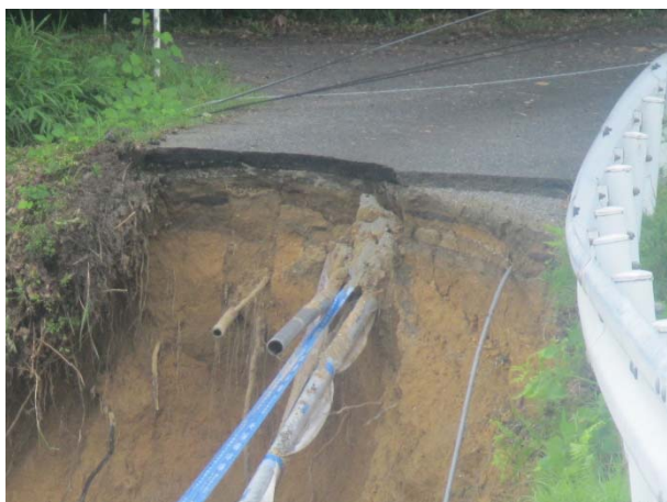
写真-1 堤体内埋設管 堤体左岸より望む
