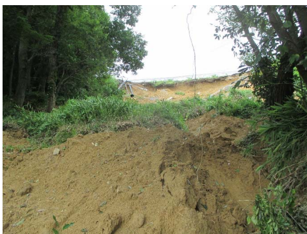
写真-5 堤体崩壊部 堤体直下流より望む
