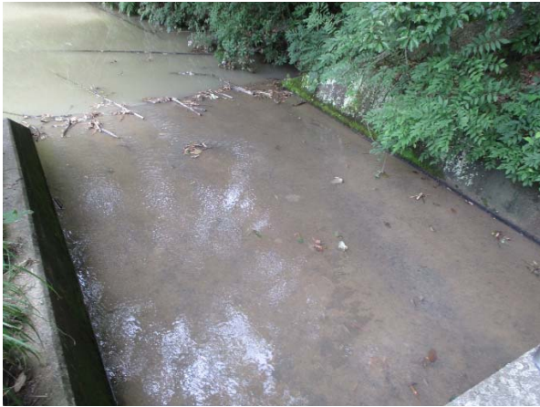
写真-17 上池の洪水吐 洪水吐から貯水を排水しており常時満水位
