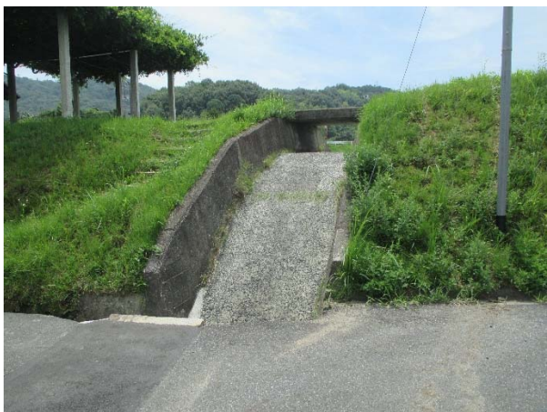
写真-7 洪水吐 堤体下流より望む
