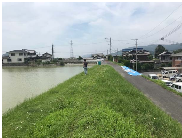
写真-8 堤体直下の市道 堤体左岸より望む
