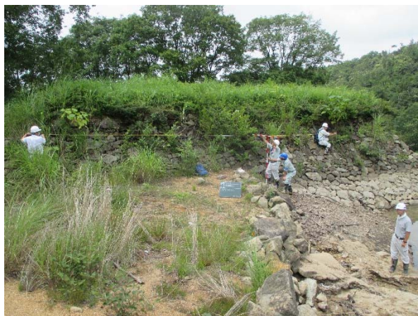
写真-2 常時水運用の水位 洪水吐クレストから石垣変色箇所 の距離
