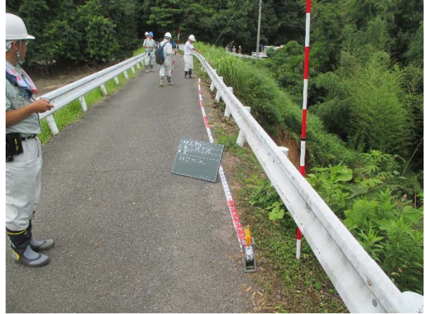
写真-18 堤体天端の様子 堤体右岸より左岸を望む
