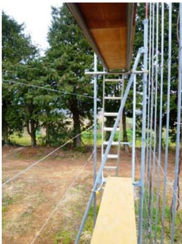
図2 地上1.6mと3.6mの床と墜落防止の燃線(左)
