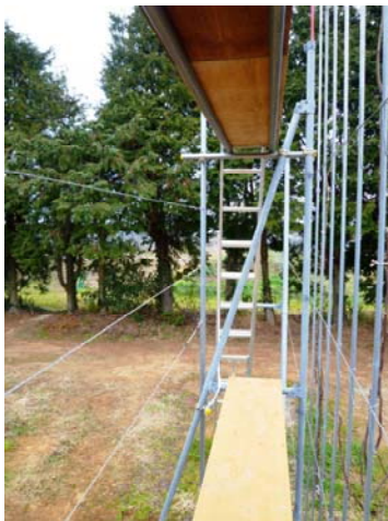
図2 地上1.6mと3.6mの床と墜落防止の撚線(左)
