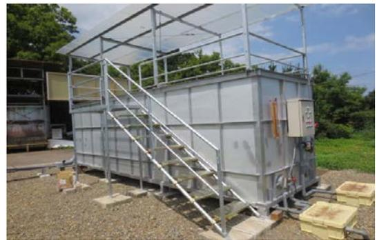
図2 ユニット型脱臭装置
