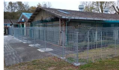
カーテン式豚舎には隣接して設置
