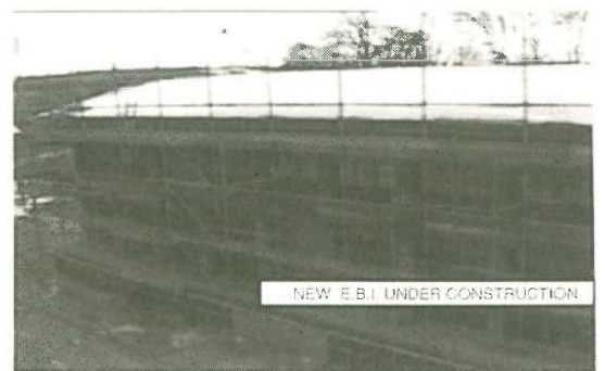
写真3 英国サンガーセンター、増設中の新実験棟
