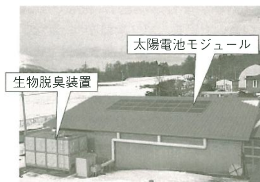
図5 自然エネルギー活用型高品質たい肥化装置
