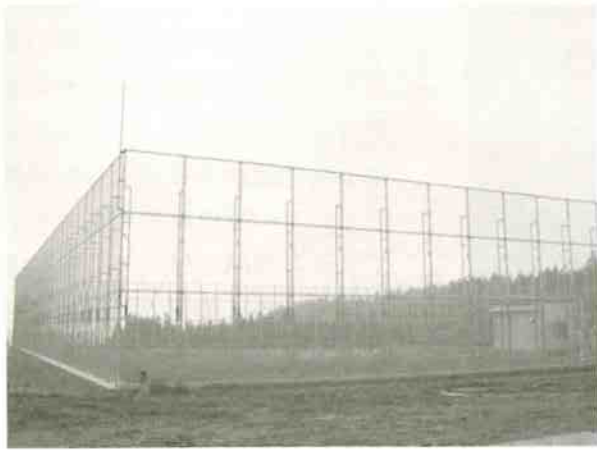
図3 野外栽培を実施している隔離ほ場は、高さ8mのフェンスと深さ1mのコンクリート壁で囲まれている
