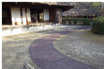
写真3 奈良県大和郡山市の公園に試験施工された半炭化処理舗装材の遊歩道（奈良県森林技術センター提供）
