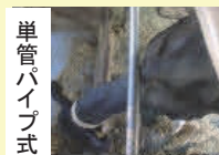
単管パイプ式
