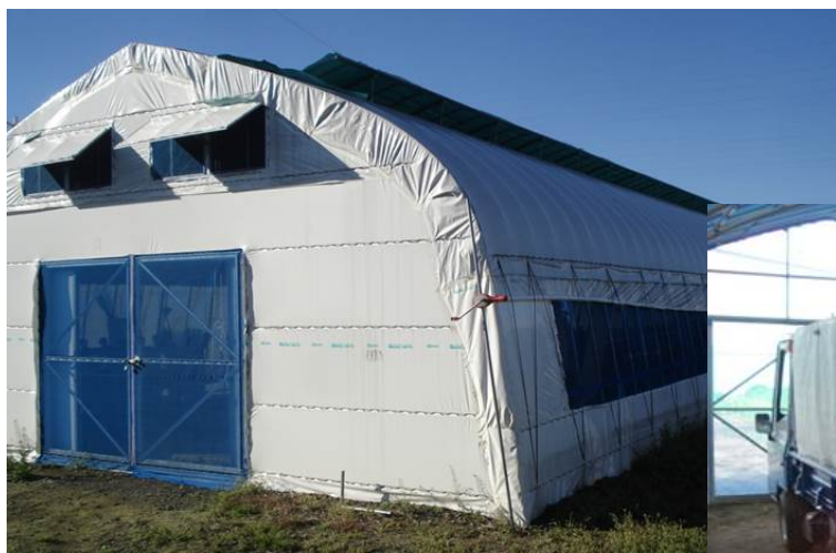
写真1 パイプハウス型の蚕室
