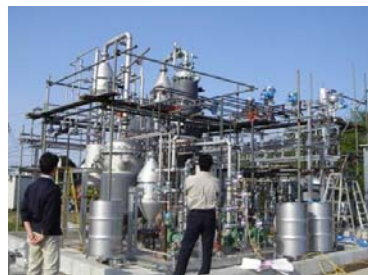
図2 建設中のディーゼル代替燃料製造 実証化プラント(400L/日)
