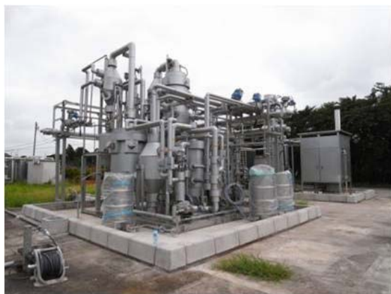
図1 実証プラント(設計製造能力:400 L/d(146 KL/y))
