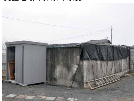
全景(装置倉庫および貯水タンク(50 m 3 ))
