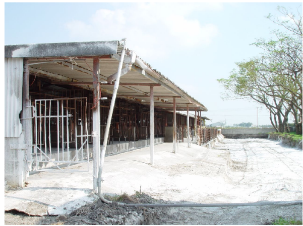
写真3-19 防疫分離帯の設置
