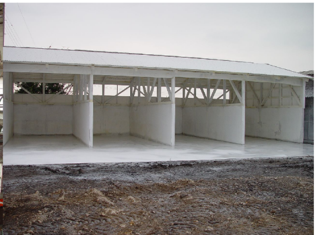
写真3-20 堆肥舎の消毒
