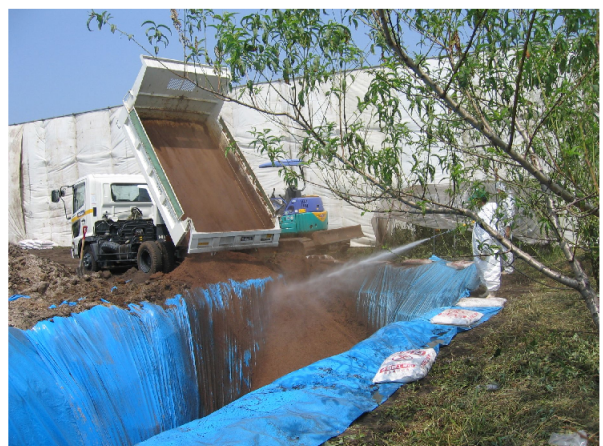
写真3-10 汚染物品の埋却・消毒
