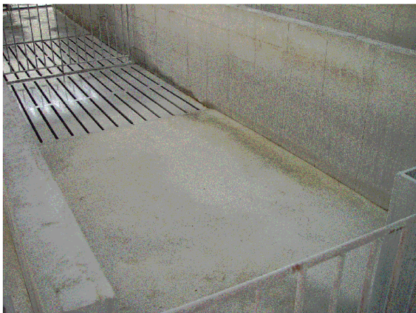
写真3-6 消毒後の状況
