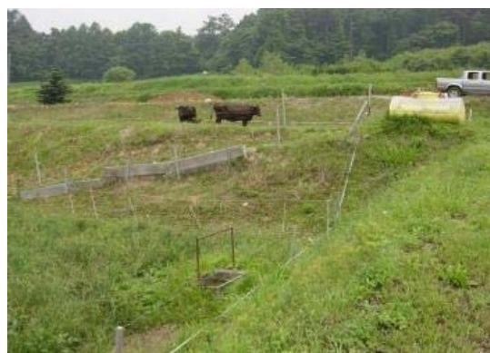
棚田放牧地の法面における牛誘導路の設置
