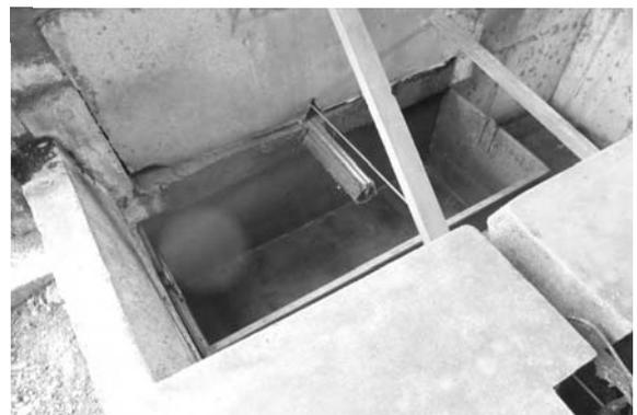
スクレーパーの稼働頻度、設備の状態、洗浄水量、遊び水量、飼料性状(マッシュ、クランブル等)が発生汚水の質に影響する。
