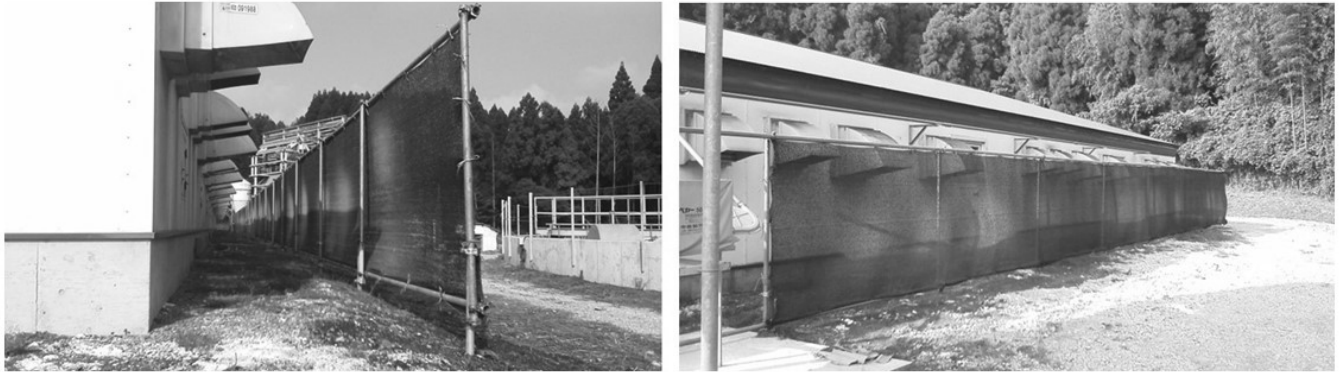
排気口への遮へい壁の設置
