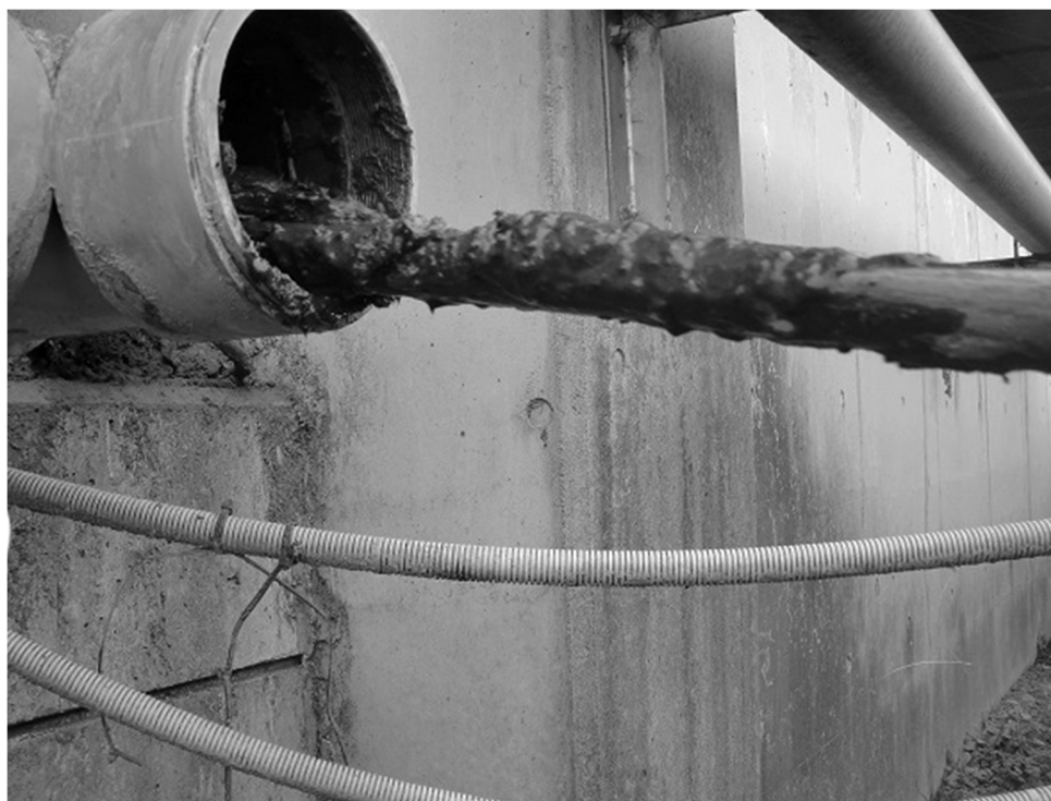
図3 排気配管経路内に設置したステンレスメッシュ製の簡易除塵フィルターに付着した泥濁化した堆肥粉塵
