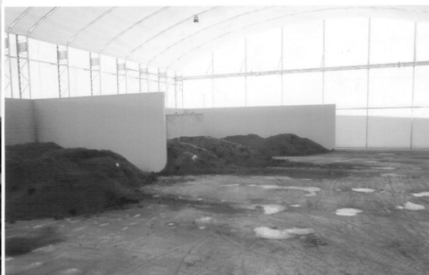
図 4 堆肥専用の保管ヤード
