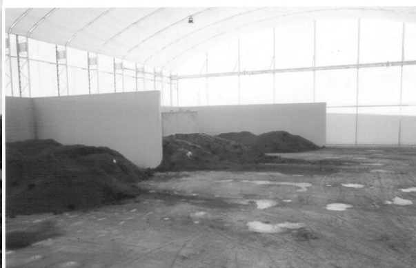
図 4 堆肥専用の保管ヤード
