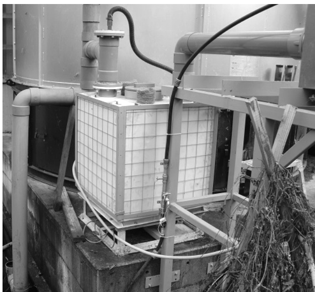
図 5 アンモニア回収装置
