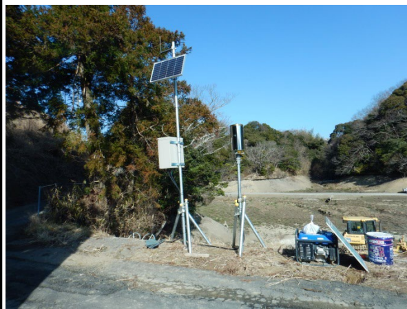
水位計+雨量計、転倒マス
