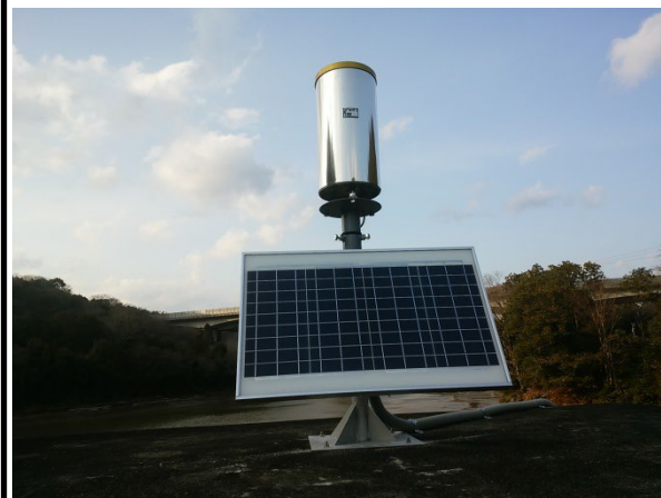
雨量計、ソーラーパネル
