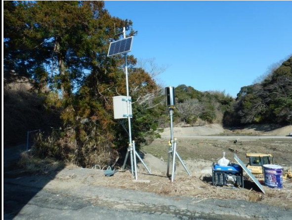
水位計+雨量計、転倒マス
