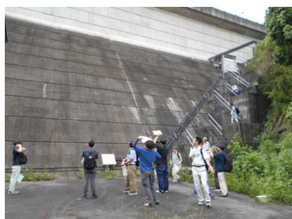
下流側堤体 (ダム機能保全Ⅱ研修)
