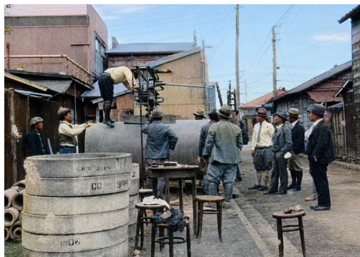
図 22* コンクリート管の外圧試験 2 （場所不明、1936 年 6 月 11 日）
