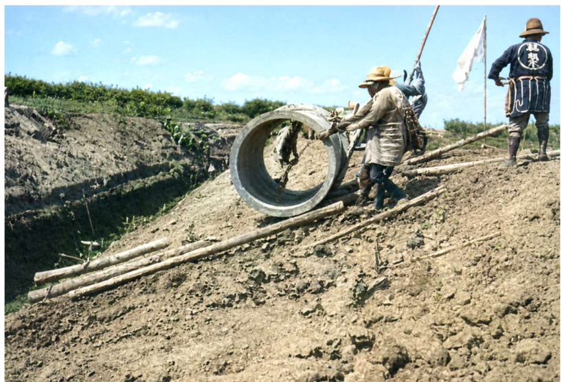
図 24* コンクリート管を溝に下ろす
