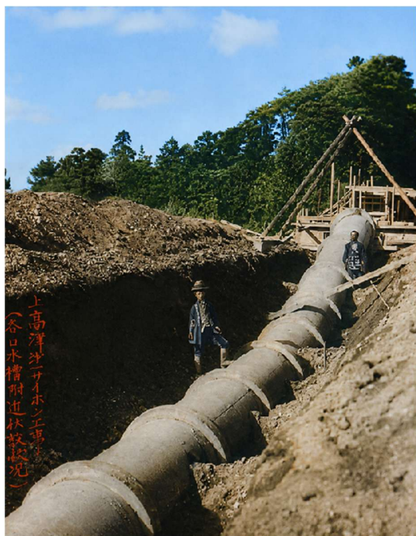
図 15* 小野川用水の上高津第一サイフォンの建設風景（1936～37 年頃） 撮影位置：図 1 の④付近
