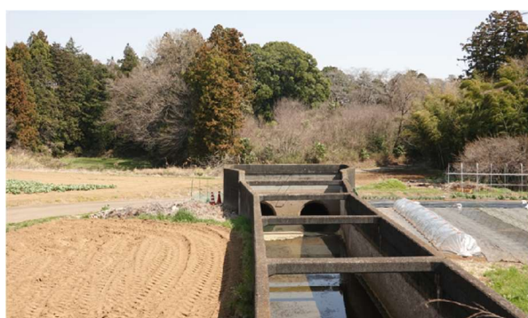
図 16 現在の土浦用水の下広岡サイフォンの流出口付近（2026 年 4 月）、小野川用水と類似したコンクリート管がみられることから類似した構造であることが推察されます。【地理座標】36.0678, 140.1612
