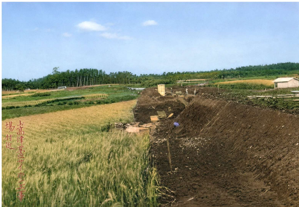
附録 図 1* 上高津第二サイフォンの工事風景(図 1 の⑧付近、土浦市上高津新町、1936 年頃) 現在もこの付近の一部には小野川用水が現役だった頃を思い起こさせるような土地利用や微地形が残されています。
