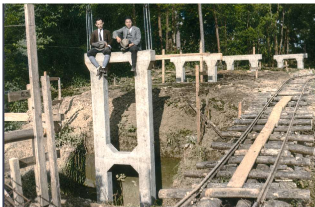
図 10* コンクリート掛樋の建設 (1936 年 9 月または 11 月)
