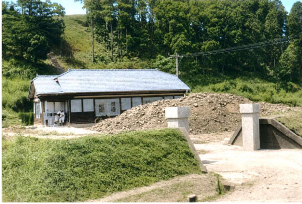
図 5* 揚水機場(ポンプ場)の建屋(1938 年頃)
