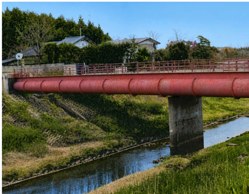
図 18 花室川の河川改修後の小野川用水の下広岡水管橋（藤澤, 1990, p431）
