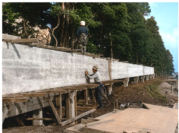
図 8* コンクリート掛樋の建設(1936 年 7 月 12 日)
