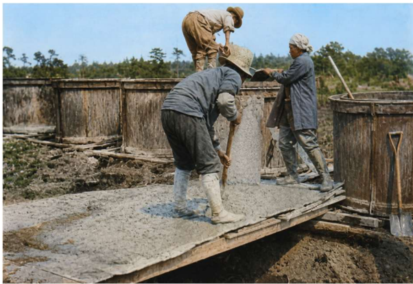
図 19* 現場打ちによるコンクリート管の製造 （場所不明、1936～37 年頃）
