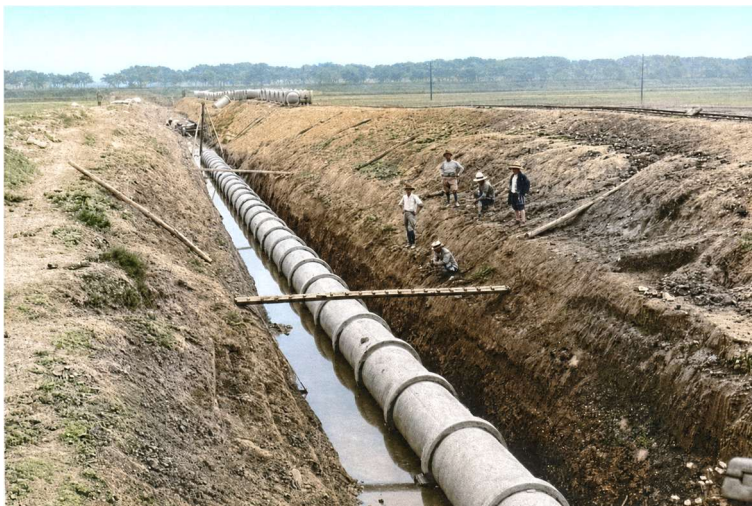
図 2* 取水地点—揚水機場間の暗渠埋設工事(図 1 の①地点付近、1936 年 7 月 11 日)、遠方にみえる樹木帯は桜川の堤防上のもの【地理座標】36.0774, 140.1851
