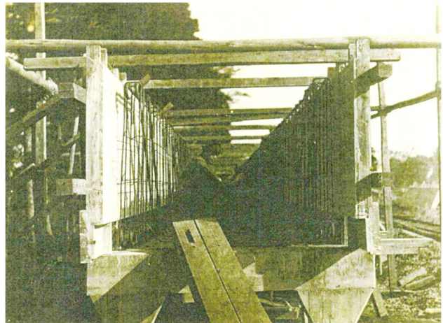
図 9* コンクリート掛樋の建設 (1936 年 7 月頃か?)
