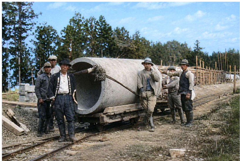
図 23* トロッキに乗せてコンクリート管を運ぶ
