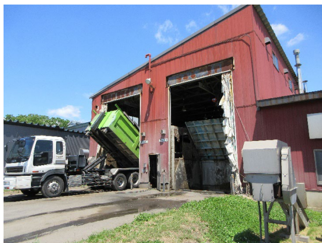
図2 家畜排せつ物の原料槽への投入
