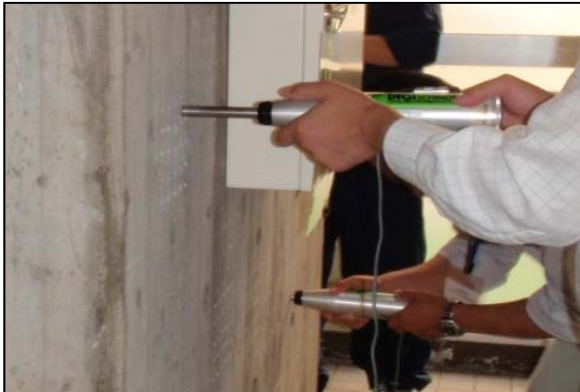
壁面の強度測定状況
