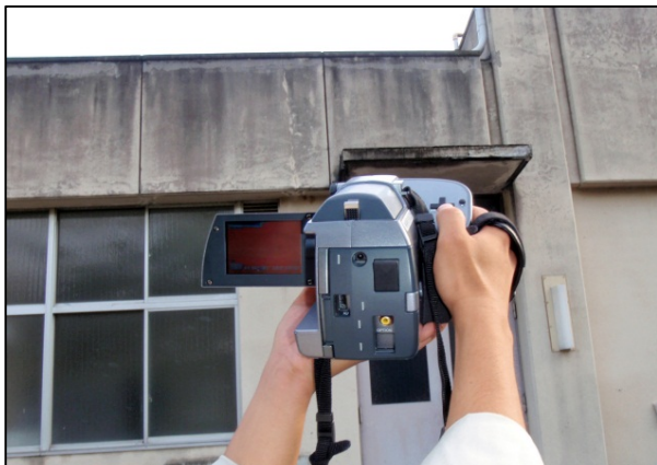
コンクリート壁面部調査状況
