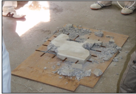
鉄筋腐食状況の目視確認状況
