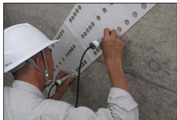
超音波法による測定状況例
