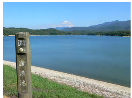
写真2 出色の農業土木技術者・空海が築造に携わった満濃池
