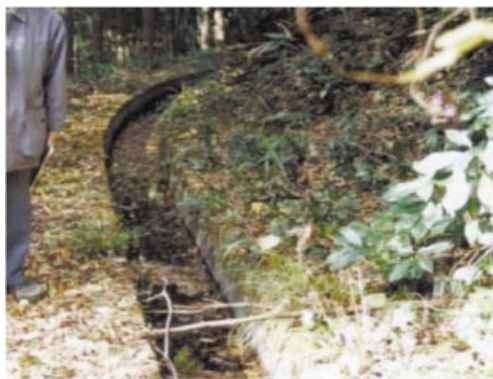
Fig.3 水路と管理用道路 (鳥取県日南町宮内東井手地区)
