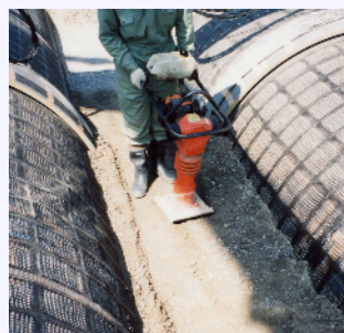
砕石の撒き出し、転圧
