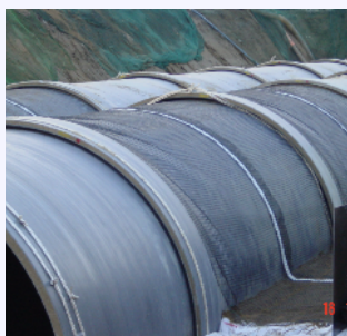
ジオテキスタイルの敷設
