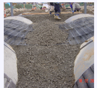
砕石の撒き出し、転圧
