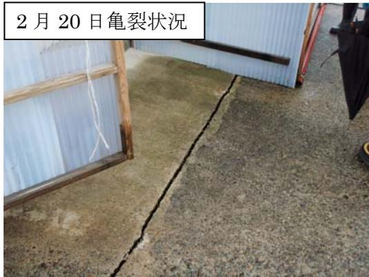
2 月 26 日、27 日に集落全体の調査を行ったところ、ほかに宅地内亀裂、道路側溝と舗装面に隙間及び舗装面の亀裂等が発見されました。住民に聞き取りをしたところ、今冬季の降雪前にはなかったとのことでした。
