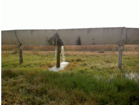
Fig. 10 支柱が沈下したためにフリユームの中央部に曲げひび割れが発生し, 漏水
