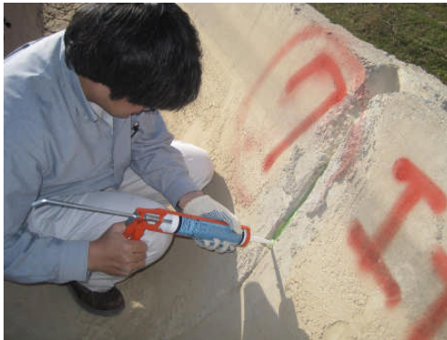
Fig. 23 継目の漏水防止応急対策に係る現地指導（ウレタンを注入）
