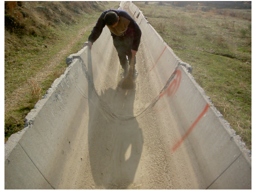
Fig. 22 補修前の清掃（作業しているのは試験当日バザールで雇ったムニエル氏（本職は左官屋さん））
