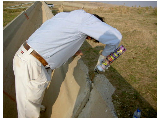
Fig. 23 継目の漏水防止応急対策に係る現地指導（ウレタンを注入）
