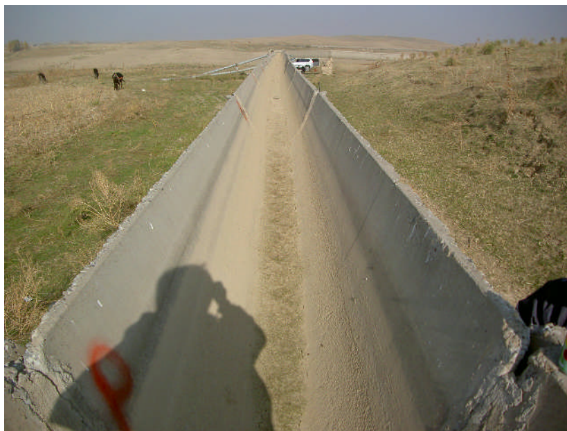
Fig. 20 試験施工現場 (清掃前)
