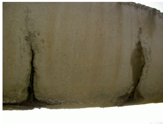
Fig. 10 支柱が沈下したためにフリユームの中央部に曲げひび割れが発生し, 漏水
