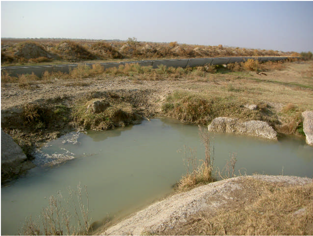
Fig. 8 曲がり部でのライニングの消失
