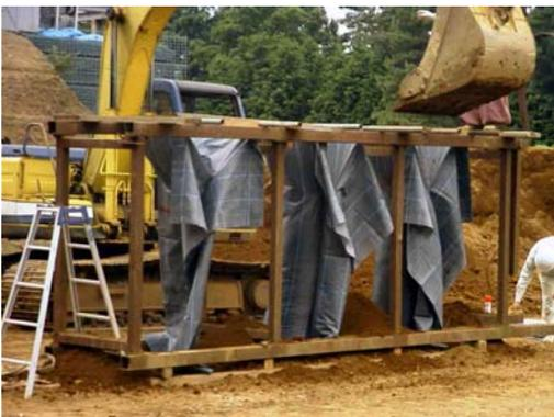
図-4.2.5 土のう作成枠による中詰め材充填状況
