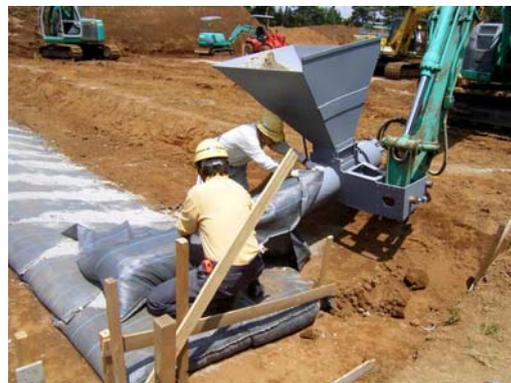
図-4.2.4 土のう作成機による中詰め材充填状況
