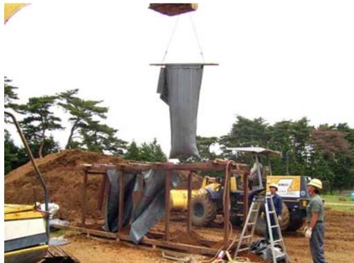
図-4.2.6 土のうの吊上げ移動
