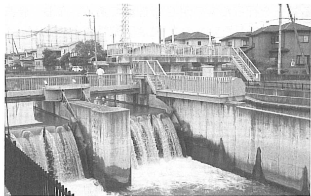
写真-1 農業水路とそれに隣接する住宅
