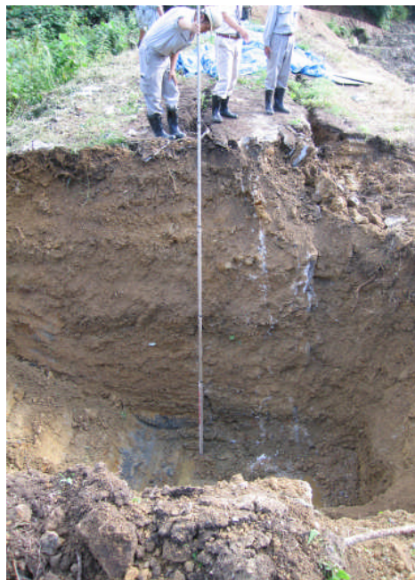
亀裂の確認状況
