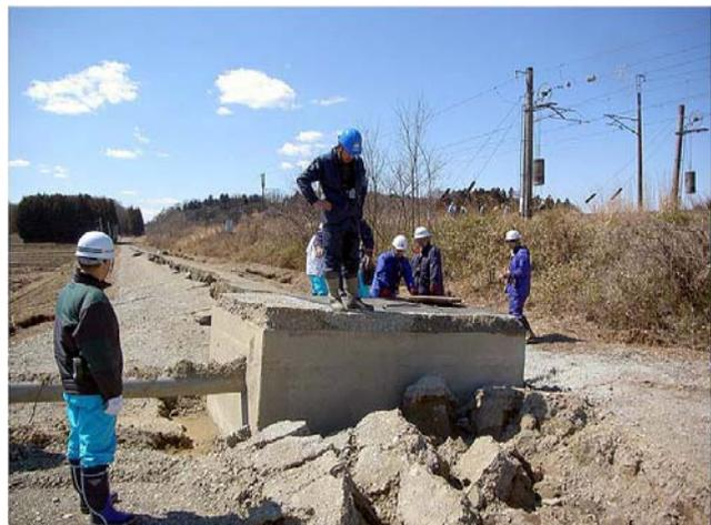
図1 液状化で浮上した空気弁工
