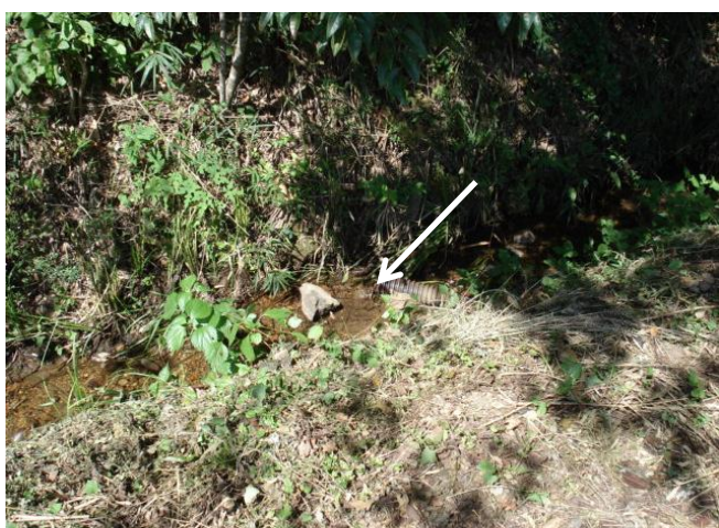
・水棲生物の移動のために水田と水路を結ぶために設置したパイプ魚道(矢印の先)。
