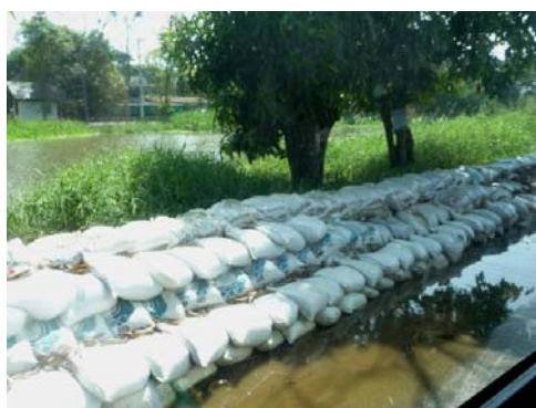
Pic.1 土嚢による堤防の補修（①地点）
