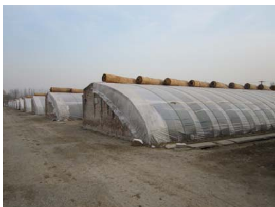
写真4 日光温室は全て東西棟です。無暖房による保温を主目的として設計されています。
