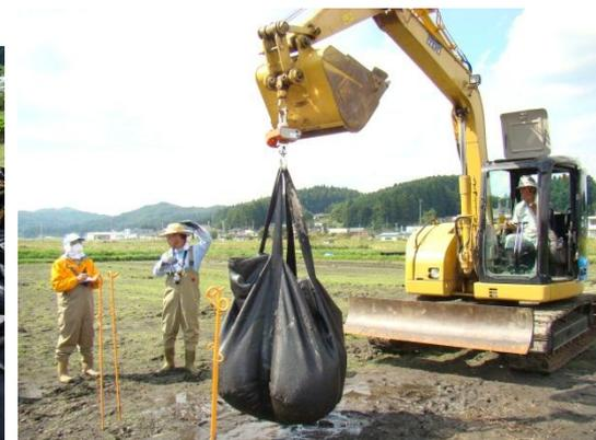
e) 分離した土壌の自然乾燥とフレコンバック詰め作業
