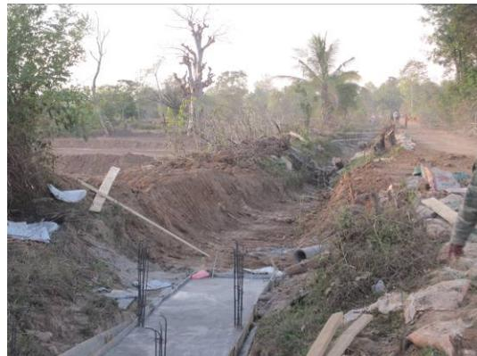
写真2 洪水で破損した幹線水路の修復 (サバンナケット県、2011年12月)
