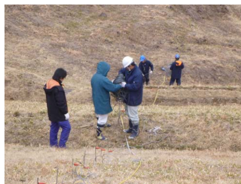
現場測線設置
