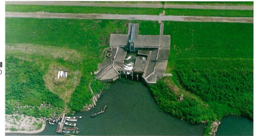
旧利根加揚水機場 (仮設ポンプによる取水状況)
