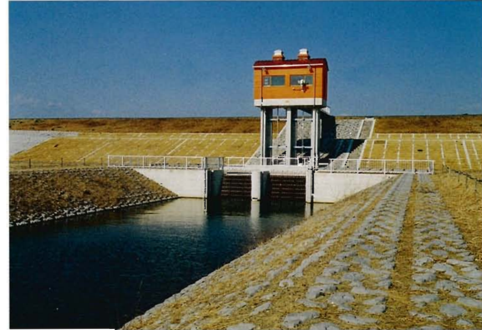
新利根加揚水機場
