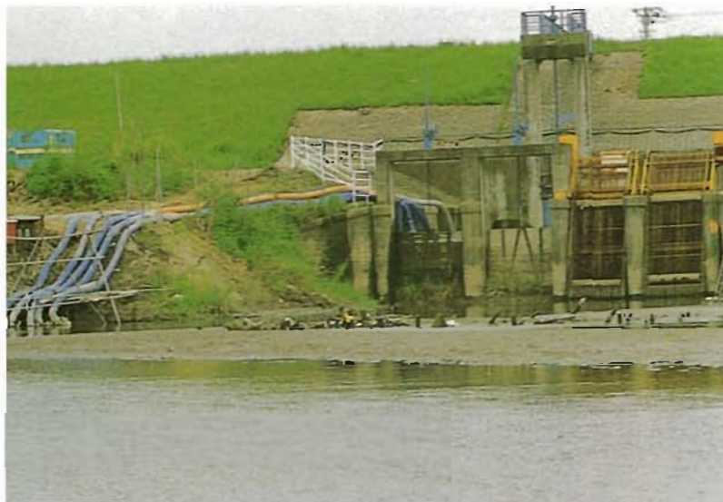
旧利根加揚水機場（仮設ポンプを使用しての不安定取水状況）
