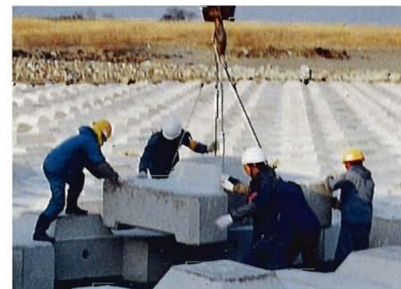
既設護床工の補修
