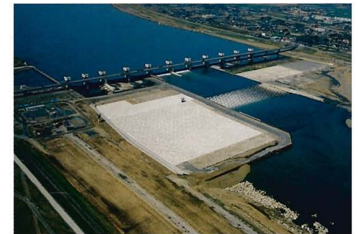
③ 第二期工事 (右岸側)
