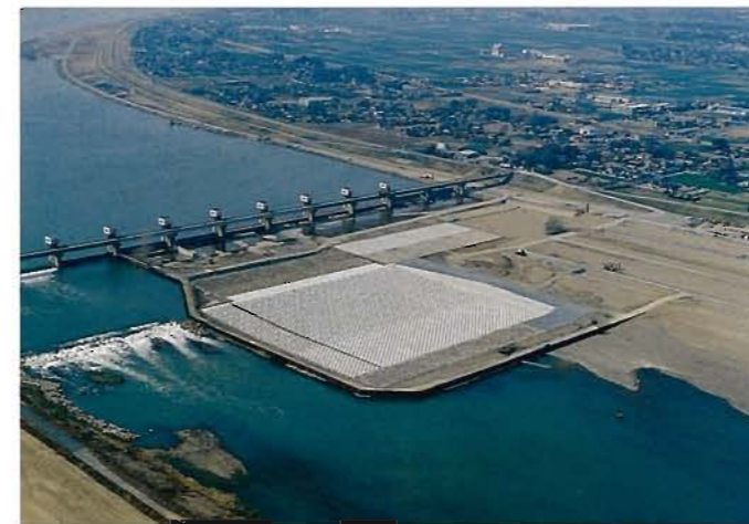
② 第一期工事 (左岸側)
