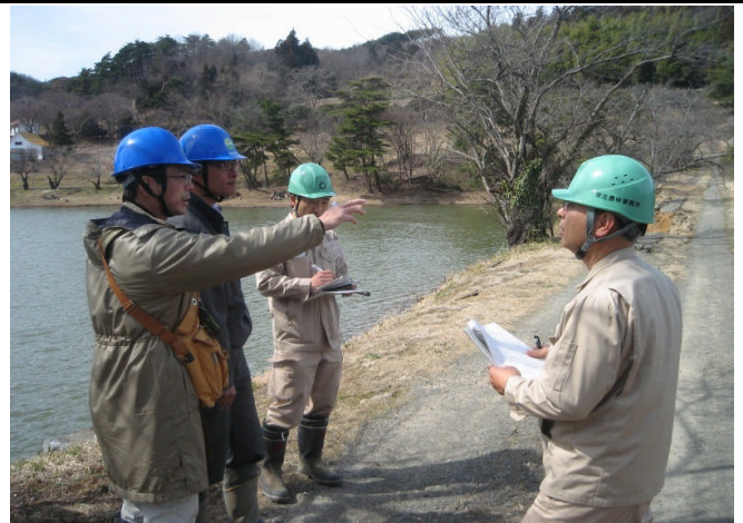
【今後の変状の確認方法等の助言】 決壊等の被害が拡大しないように、貯水位管理の方法や漏水、変形などの堤体監視方法について助言した。
