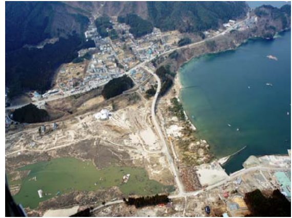
【岩手県山田町船越の浦の浜農地海岸の被害】 写真右側の浦の浜からの津波と左の陸側(南船越漁港)から遡上した津波が合流した地区。浦の浜側の海岸堤防は完全に倒壊し、低地部の施設は完全に流失しているが、国道45号線沿いの集落は被害を免れている。
