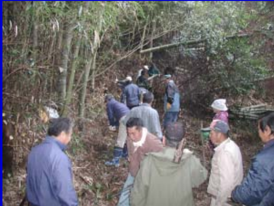
散策道設置工事
