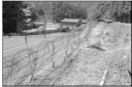
図 3 立体型多獣種対応侵入防止柵
