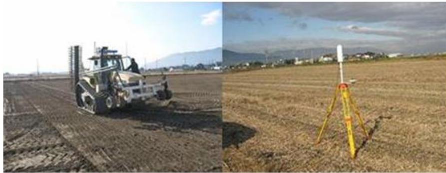
図1 岐阜県海津市における現地試験
