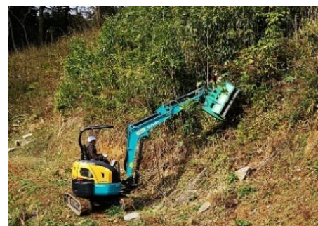
島根県・大田市 油圧ショベル装着型フレールモアによる 現地実演
