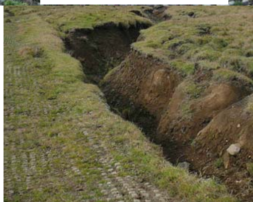
侵食防止ブロック脇での新たな侵食
