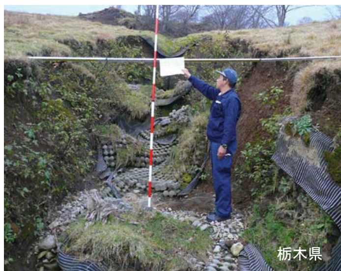
侵食防止ブロック施工箇所での再侵食
